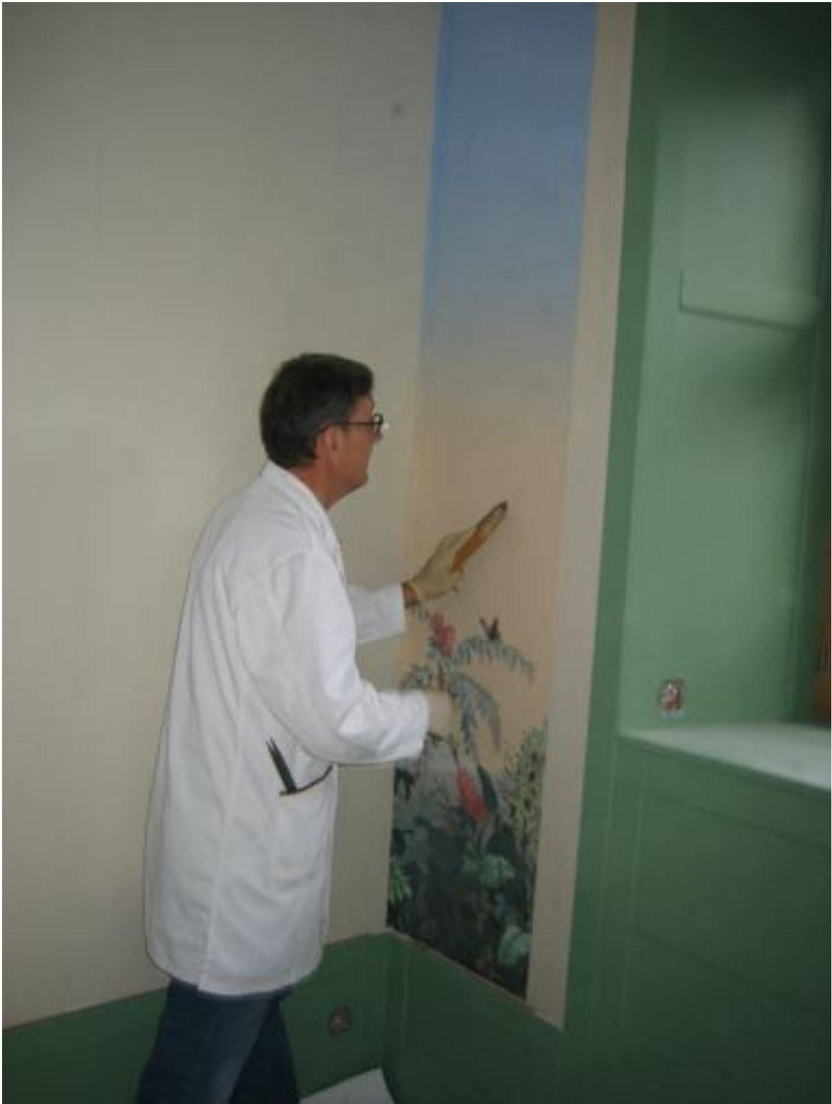
Die erste Bahn wird in der vorbestimmten Raumecke tapeziert. An diese Bahn schließt sich mustergleich die letzte Bahn des Motives an
