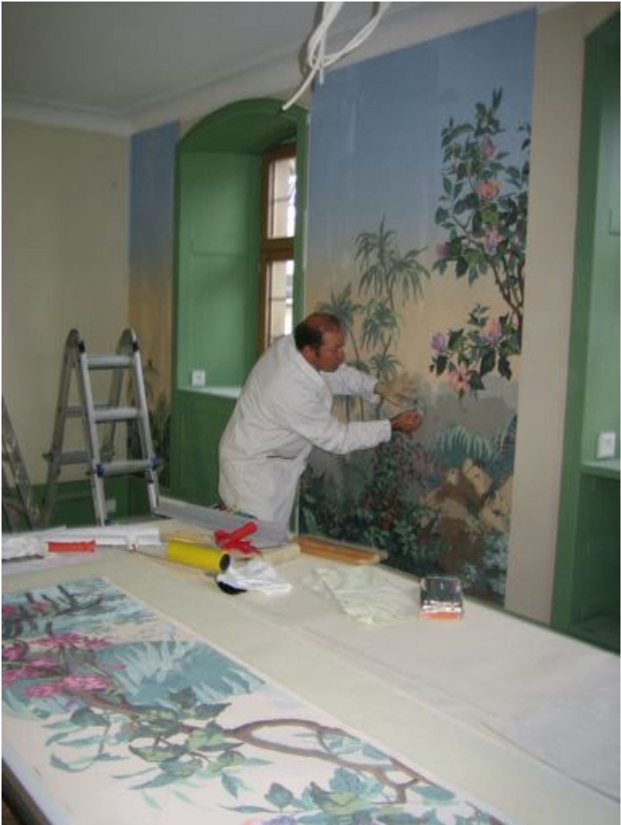
Da der Musterrapport bei Handdrucktapeten nicht so präzise wie beim Maschinendruck ist, wird bei Bedarf mit Gouachefarben retuschiert.
